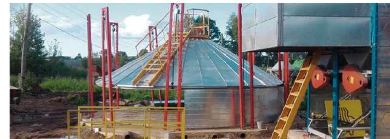
**Шаг 6.** Установка транспортера загрузки. **Шаг 7.** Установка системы автоматики и контроля.
